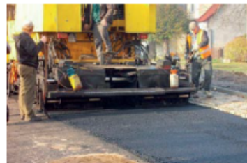
Przebudowa Placu Targowego w ciągu drogi powiatowej
